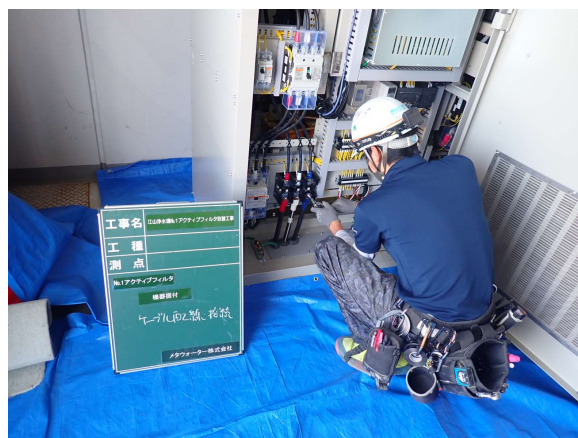
電気設備部品取替
