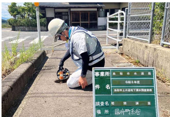
相関式漏水調査
