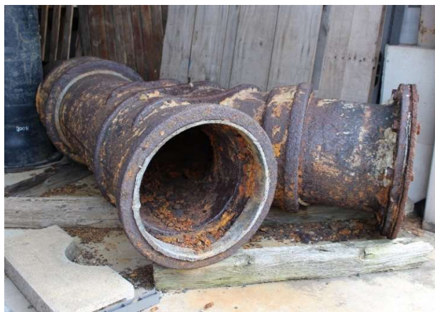
撤去したCIP(昭和9年頃布設の管)
