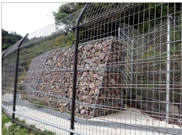
法面落石防止対策工事(江山浄水場)
