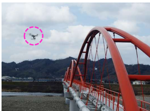
ドローンを用いた添架管調査
