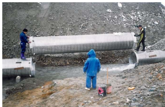
集水管機能回復工事(叶水源)
