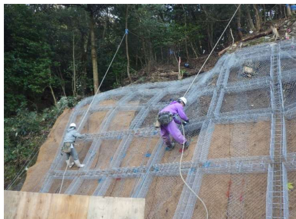
斜面安定工事(上町配水地)
