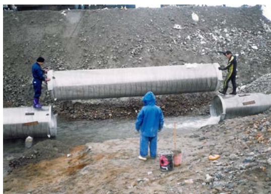
図 2.34 集水管機能回復工事（叶水源）
