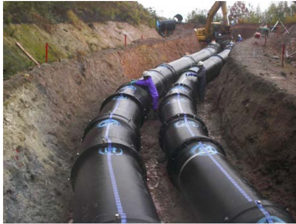
図 2.21 耐震管布設工事
