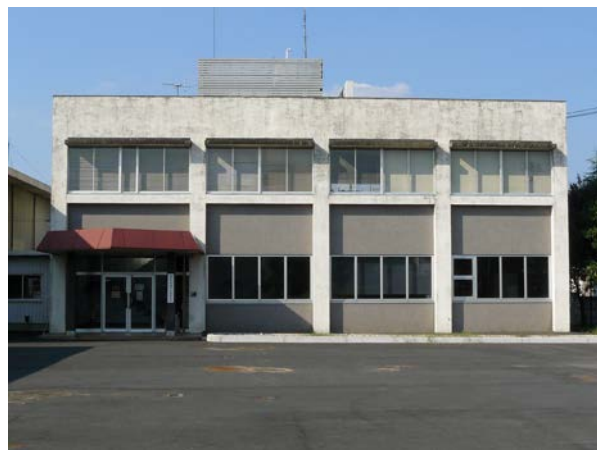
図 4.2 水質検査室（叶水源地）
