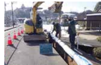
送水管布設工事(河原地域)
