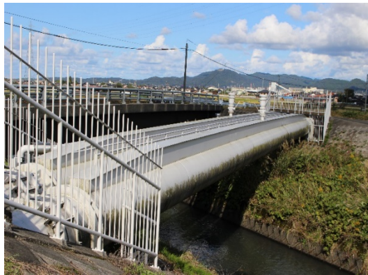
岩崎橋水管橋
