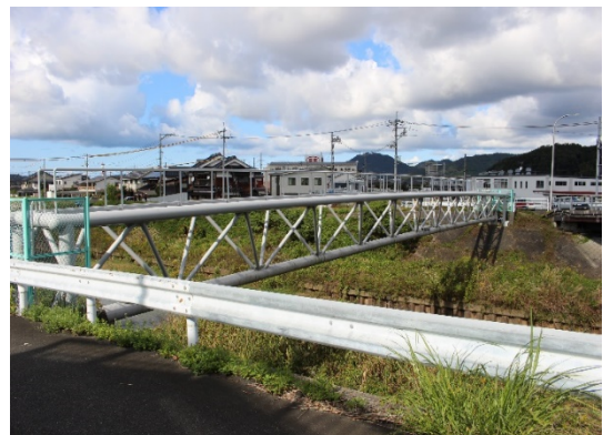
西大路水管橋
