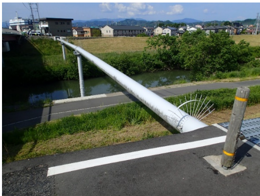
興南大橋水管橋
