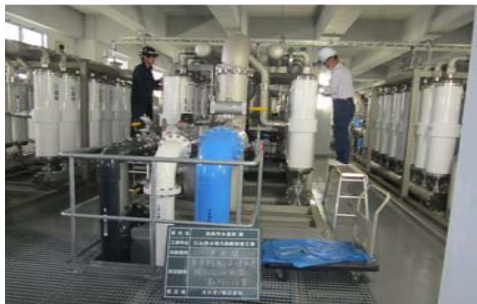
江山浄水場ろ過膜取替工事 (ろ過膜取替状況)
