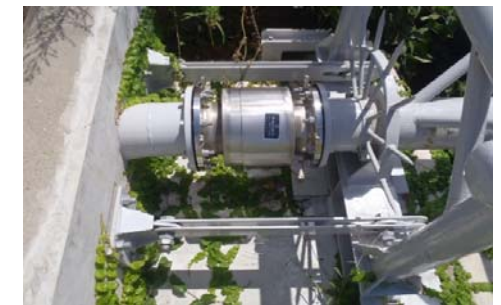
智頭橋水管橋ほか耐震補強工事 (弥生橋水管橋)
