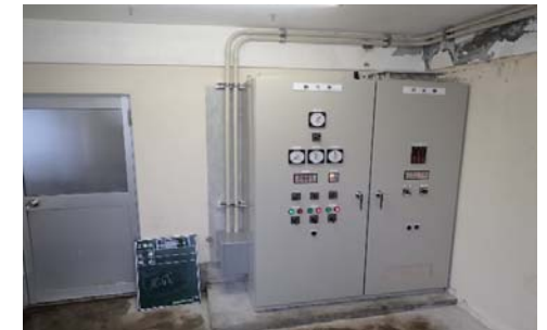
八幡浄水場電気計装設備更新工事 (動力盤、計装盤据付完了)
