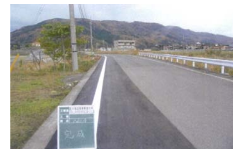
河原町山手地内配水管布設その3工事 (完成)
