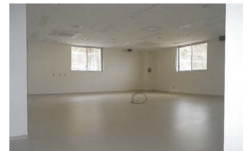
江山浄水場水質検査棟新築(建築主体)工事 (有機物前処理室)
