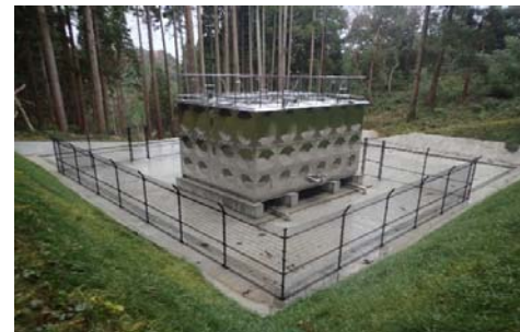
佐治町津無地域津無配水池築造工事 (完成)
