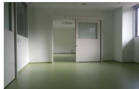
江山浄水場水質検査棟新築(建築主体)工事 (細菌準備室)
