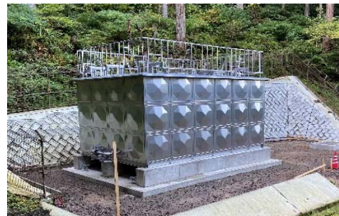
猪子地域猪子配水池築造工事 (完成)
