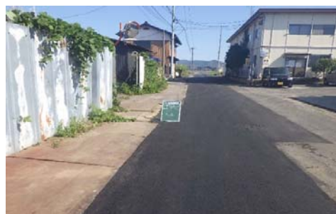
米里・若葉台系送水管布設その2工事 (完成)
