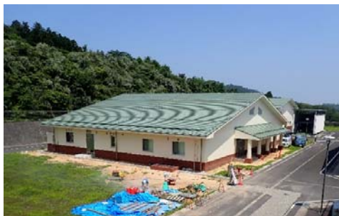
江山浄水場水質検査棟新築(建築主体)工事 (水質検査棟)
