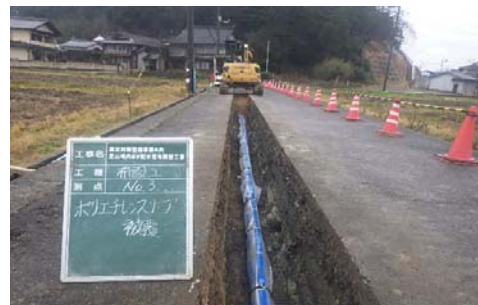
足山地内ほか配水管布設替工事 (管布設状況)
