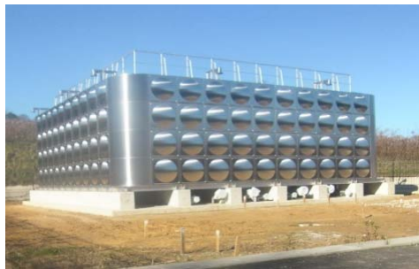
国府町宇倍野地域広西配水池築造工事 (完成)
