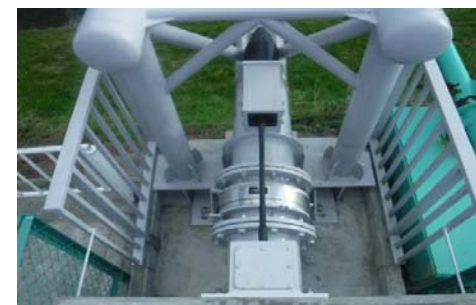
智頭橋水管橋ほか耐震補強工事 (智頭橋水管橋)
