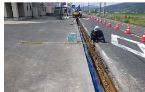
河原町布袋地内ほか送水管布設工事 (管布設状況)
