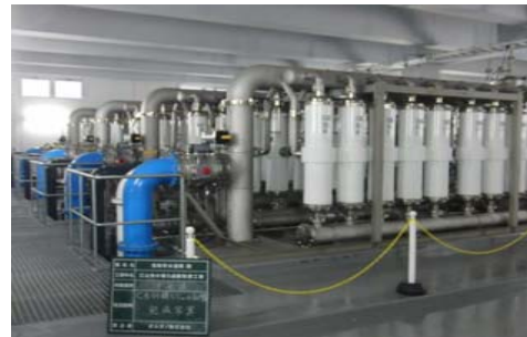
江山浄水場ろ過膜取替工事 (ろ過膜取替完了)
