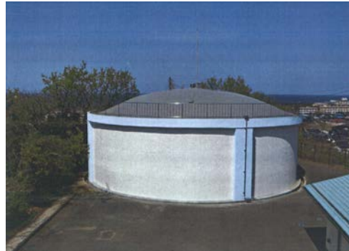
末恒No.1配水池改修工事 完成
