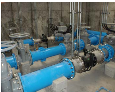
賀露ポンプ場場内配管布設工事
