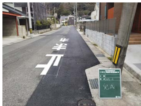
中町地内ほか配水管布設替工事 完成
