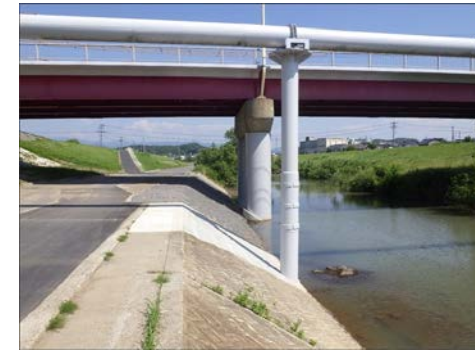
興南大橋水管橋（右岸）耐震補強工事 橋脚補強
