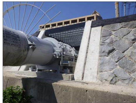
興南大橋水管橋（右岸）耐震補強工事 伸縮管設置
