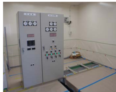
賀露ポンプ場電気、計装設備工事 （H30出来高）
