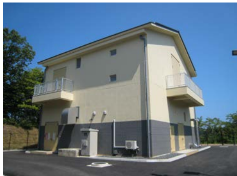
城山浄水場場内整備工事
