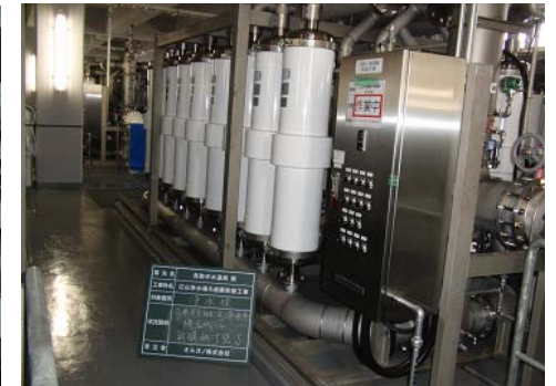
江山浄水場ろ過膜取替工事 (H30出来高)
