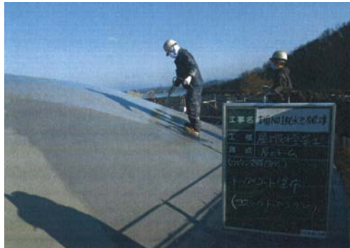
末恒No.1配水池改修工事 屋上防水塗装
