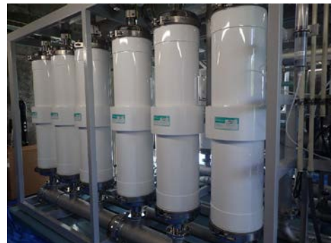
城山浄水場膜ろ過設備工事
