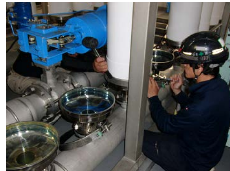
江山浄水場ろ過膜取替工事 (H30出来高)
