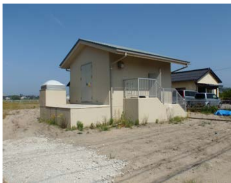
賀露ポンプ場電気室築造工事
