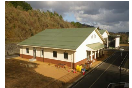
江山浄水場水質検査棟新築(建築主体)工事 現在の状況
