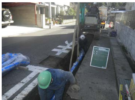
中町地内ほか配水管布設替工事 管布設状況
