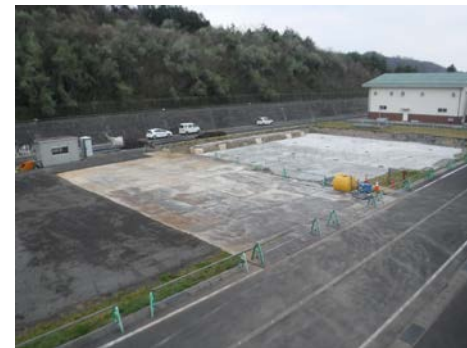
江山浄水場水質検査棟新築(建築主体)工事 平成31年3月末（実施工程13.98%）
