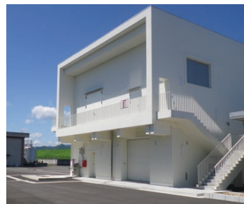
（鉄筋コンクリート造2階建） ▲叶水源地自家発電機棟
