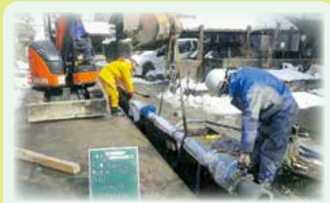
耐震管路への更新工事 管路の新設や更新にあたっては、耐震性に優れた管（耐震管）を使用しています。
