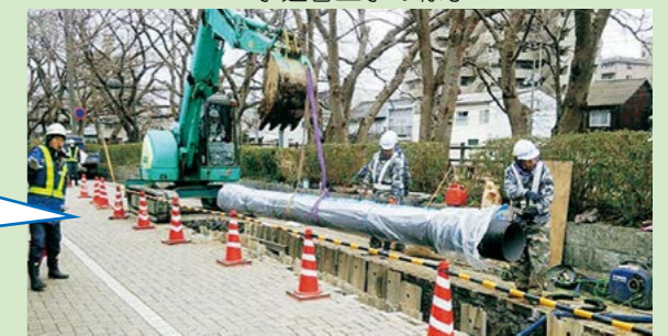
水道管工事の様子
