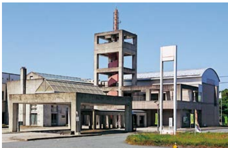
西地域水道事務所(青谷町総合支所内)
