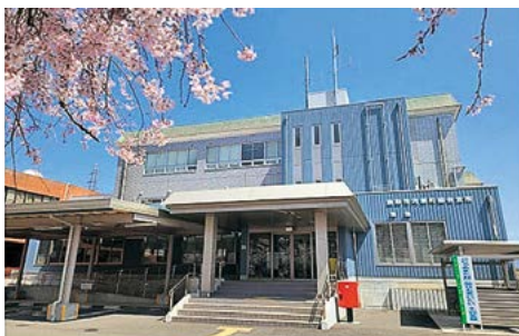
南地域水道事務所(河原町総合支所内)
