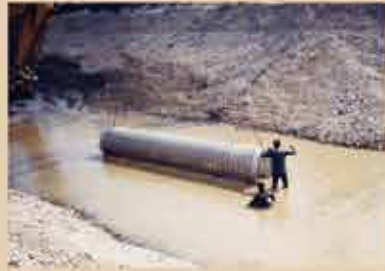
集水管の実物大模型 (江山浄水場展示)
