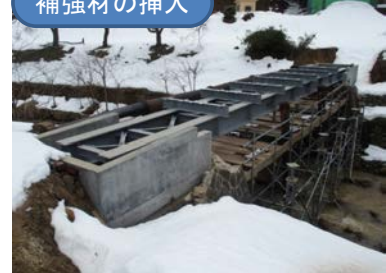
補強材の挿入
