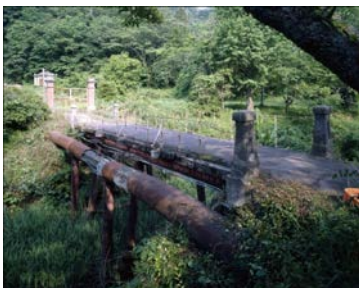
◆下流側管理橋(修理前)
