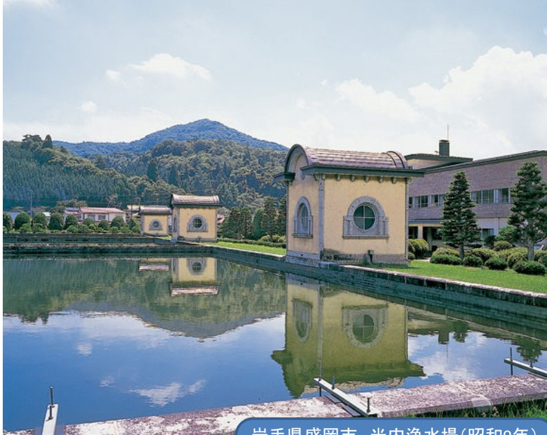
岩手県盛岡市 米内浄水場(昭和9年)
