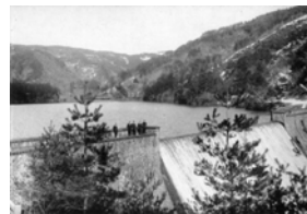
◆大正11年 重力式堰堤竣工
