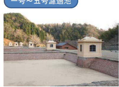
一号～五号濾過池
