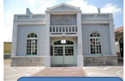
旧倉吉町水源地水道施設(昭和7年)
