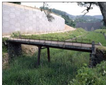
◆上流側管理橋(修理前)
