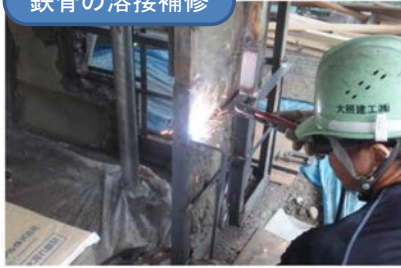
鉄骨の溶接補修
