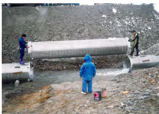
図 2.34 集水管機能回復工事（叶水源）
