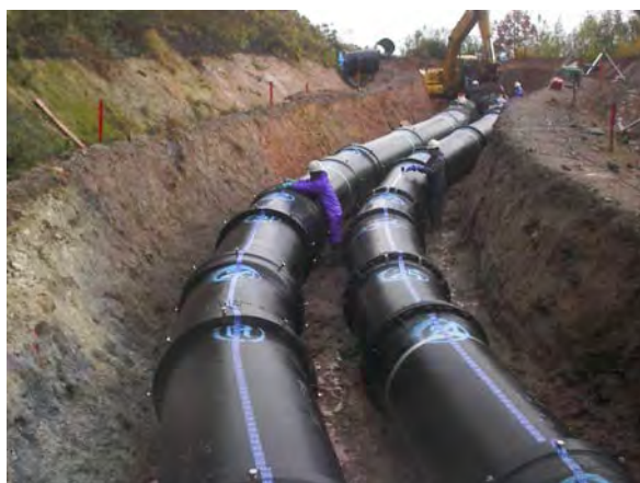
図 2.21 耐震管布設工事
