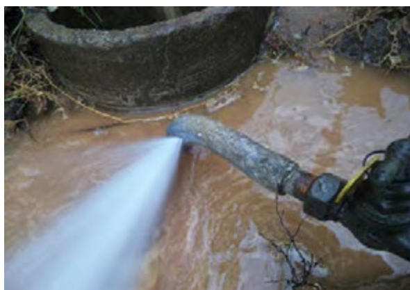
図 2.16 鉛製給水管からの漏水
